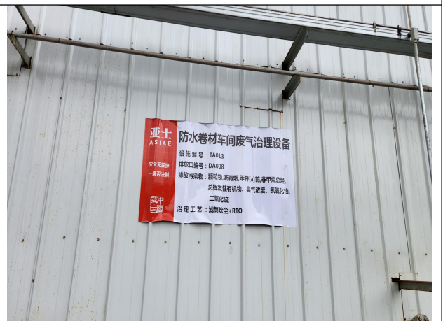
SBS 防水卷材废气、沥青罐区废气：DA008 滤筒+RTO
