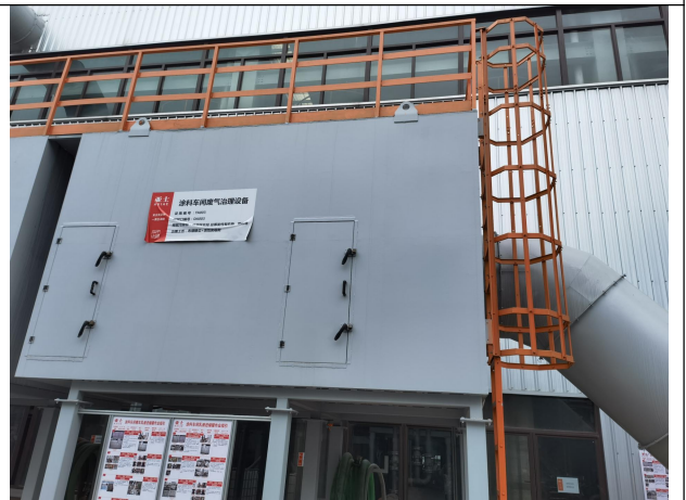
水性涂料有机物废气：DA003 布袋+两级活性炭吸附
