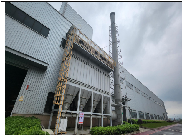
砂浆腻子粉尘和 S 防水涂料（粉料）粉尘 DA009 布袋除尘
