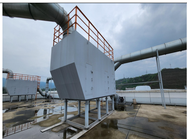
氟碳/金属饰面保温装饰板精砂除尘等含尘有机废气：DA011 布袋除尘+活性炭
