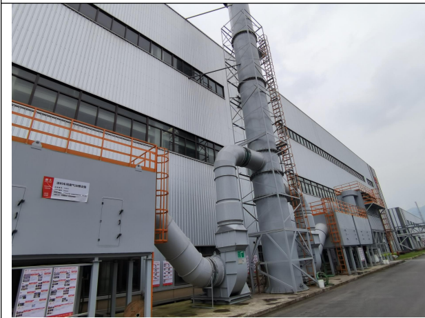
水性涂料有机物废气：DA003 布袋+两级活性炭吸附
