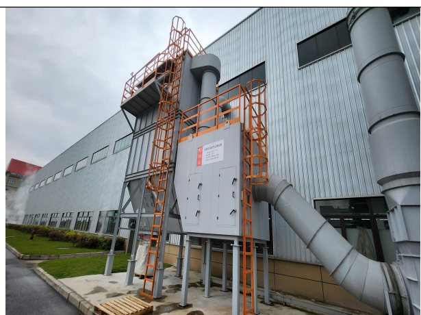
保温装饰板底板线砂光、精砂、除尘、上板粉尘
