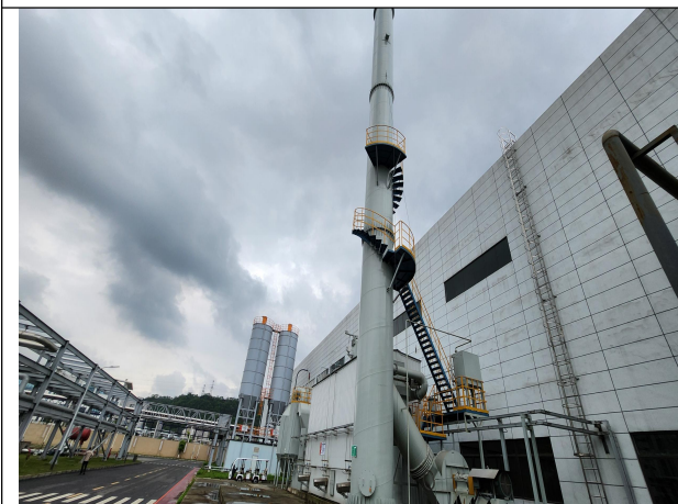
SBS 防水卷材废气、沥青罐区废气：DA008 滤筒+RTO
