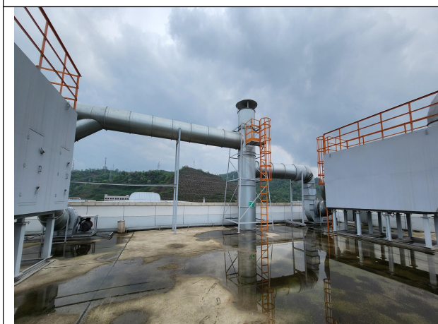
氟碳/金属饰面保温装饰板精砂除尘等含尘有机废气：DA011 布袋除尘+活性炭
