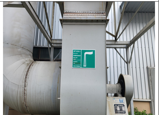
砂浆腻子粉尘和 S 防水涂料（粉料）粉尘 DA009 布袋除尘
